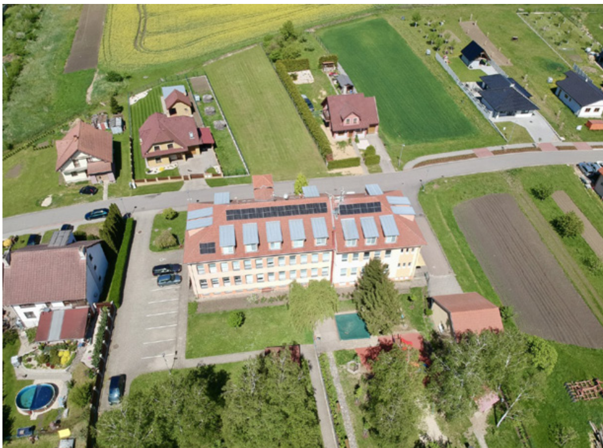
Dům s chráněnými byty sv. Anežky České obce Suchá Loz, ze kterého se sdílí elektřina v Enerkomu Slovácko. Foto Martin Machalík
