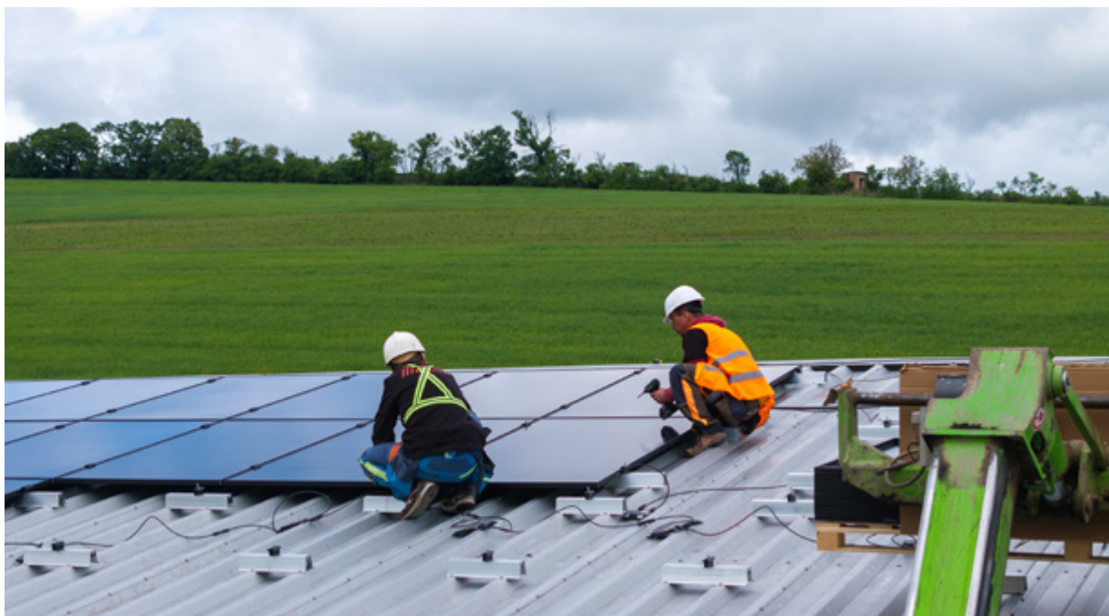
Montáž první elektrárny Energetického družstva Hnutí DUHA. Foto: Lukáš Bartl
