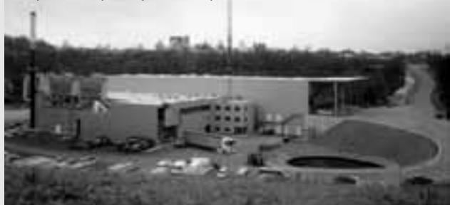
Zařízení na mechanicko-biologické zpracování odpadu v Drážďanech
