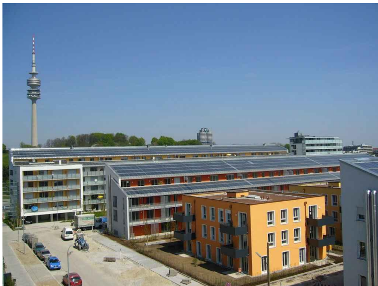
Foto: sídliště Ackermanbogen http://www.iea-shc.org
